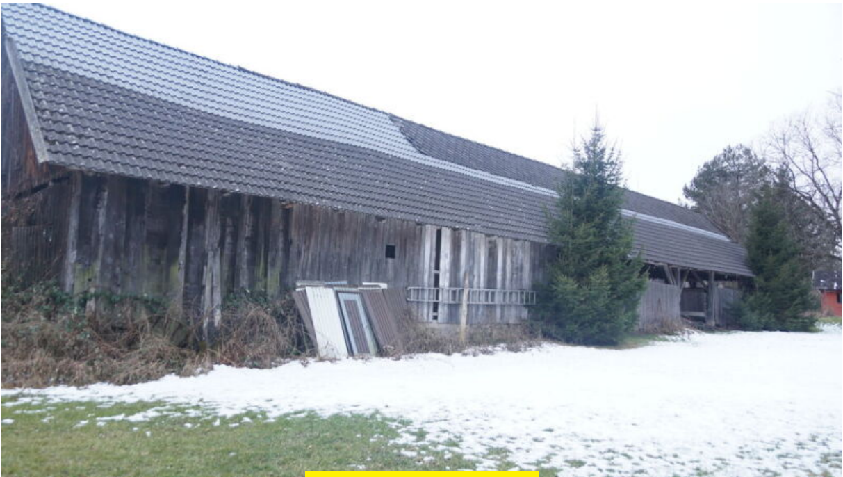
Maschinenhütte vom Norden
