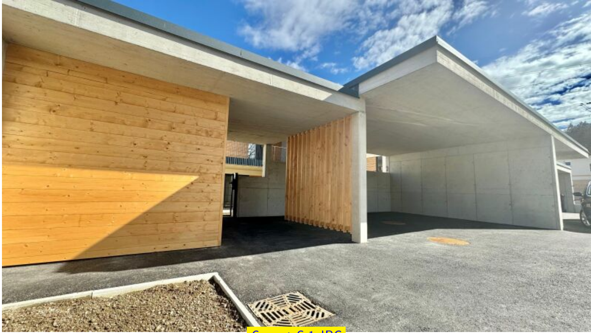
Carport C 1.JPG
