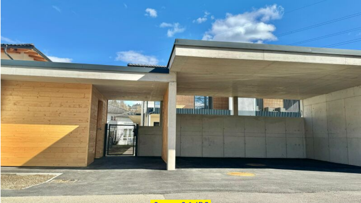
Carport C 3.JPG
